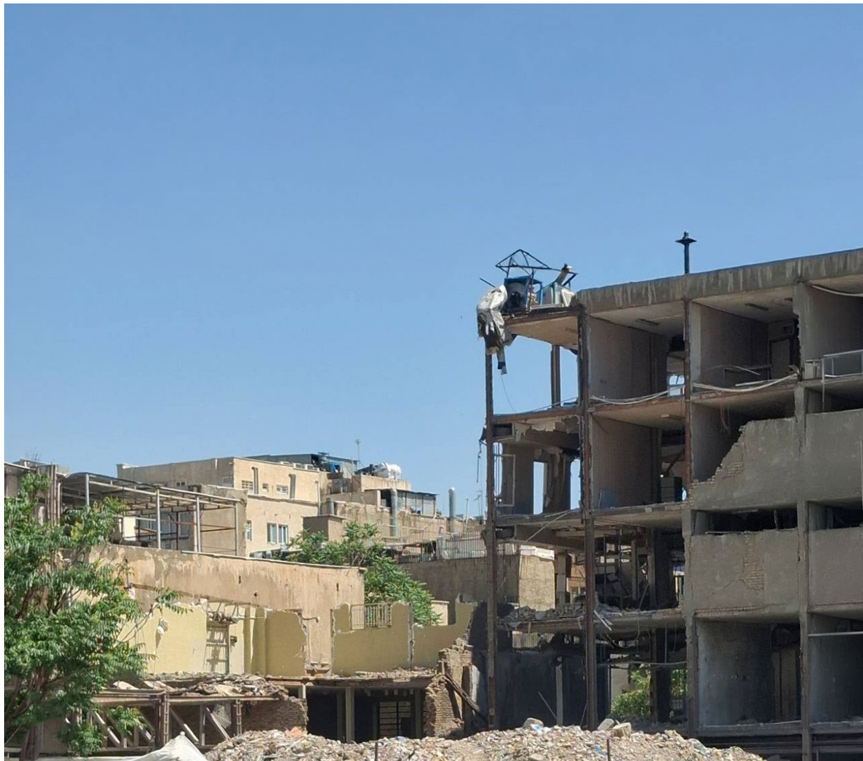
ساختمانی مسکونی در اثر حملات هوایی تخریب شده است
